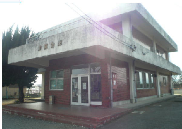
今回の補正予算で耐震診断が計上された農業会館
