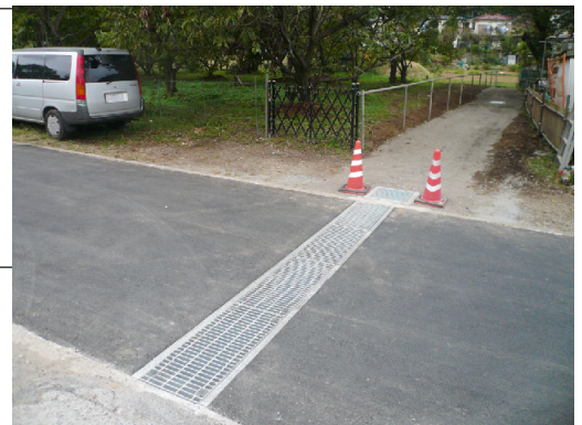
新しく出来た「横断側溝」
